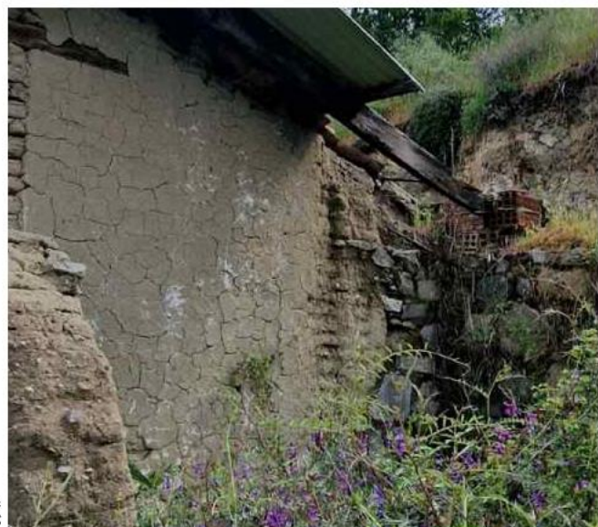
Διάβρωση Πλῆθᾶριού & Κατάρρευση Οροφής
