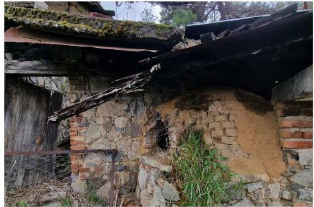
Κατάρρευση Πλάκας Σκυροδέματος Φθορά Ξύλου Παραθύρου
