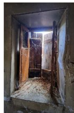
Διαβρωμένο Ανοιγόμενο Παράθυρο
