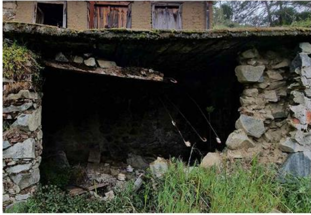
Κατάρρευση Λιθοδομής και Πλάκας Σκυροδέματος
