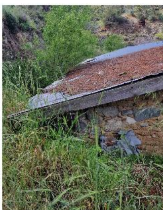
Διάβρωση Πλῆθᾶριού & Κατάρρευση Οροφής
